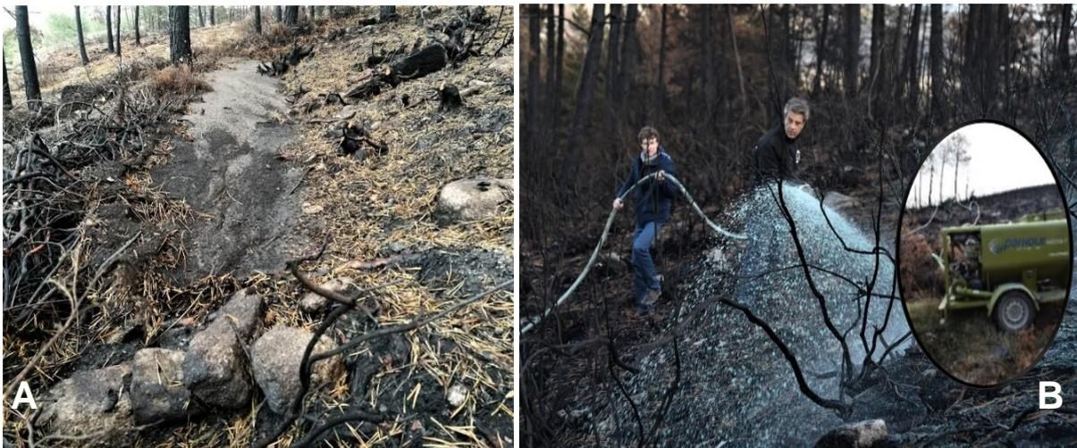
**Figura 2.** Estabilização de emergência na Serra do Alvão: **A** - aplicação de faxinas, notando-se apenas 1 mês após a sua instalação a considerável sedimentação de finos; **B** - utilização de hidrosementeira em áreas ardidas, com seleção apropriada de espécies gramíneas e leguminosas. Fotos OTI.
