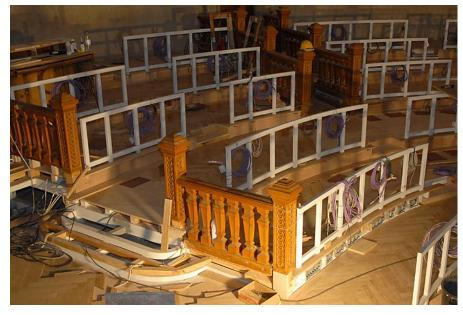
Ao nível do pavimento, prosseguem os acertos de pormenor nas zonas dos degraus e rodapés e, paralelamente, os ajustes na implantação das bancadas, a fim de que todas as infra-estruturas tenham acesso facilitado ao seu interior.
