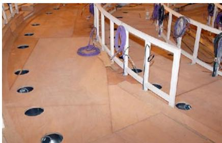
Ao nível das Galerias, encontram-se em execução os trabalhos de montagem do isolamento acústico, bem como os remates de estuque nas paredes.
