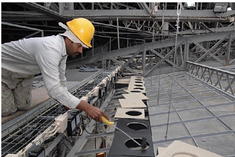
Foi concluída a passagem de cabos de alimentação de energia do Quadro Geral de Baixa Tensão até ao Hemiciclo e também passados os cabos do sistema de detecção de incêndios.
