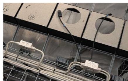
Em desenvolvimento encontra-se também a instalação das armaduras do novo sistema de iluminação ao nível da clarabóia.
