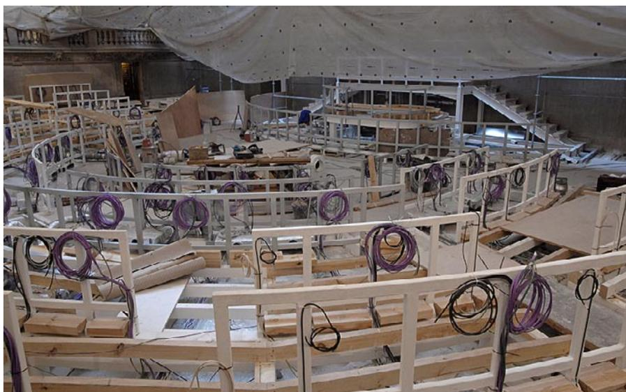
Prosseguem os trabalhos referentes à implantação dos ventilo-convectores ao nível das paredes e pavimentos das Galerias e sua interligação com o pavimento e revestimento das paredes.
