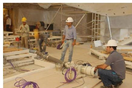
Continuam também os trabalhos de implantação das novas condutas metálicas do novo sistema de ar condicionado, estando já executados alguns dos ensaios de estanquicidade previstos.
