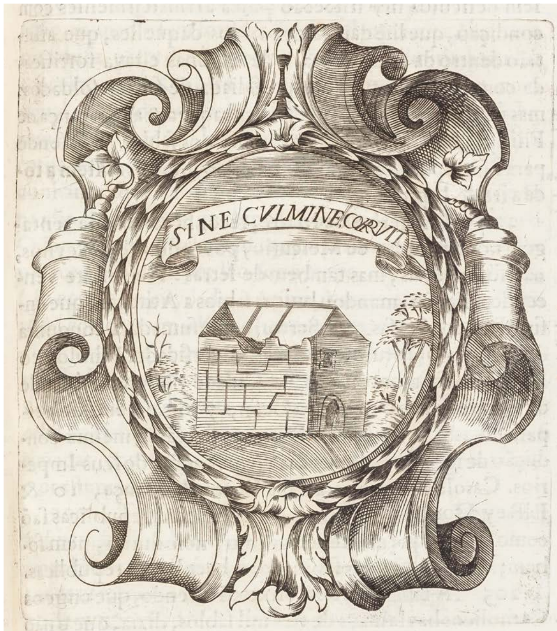
Sine Culmine, Corruit. – Sem telhado, degrada-se.
