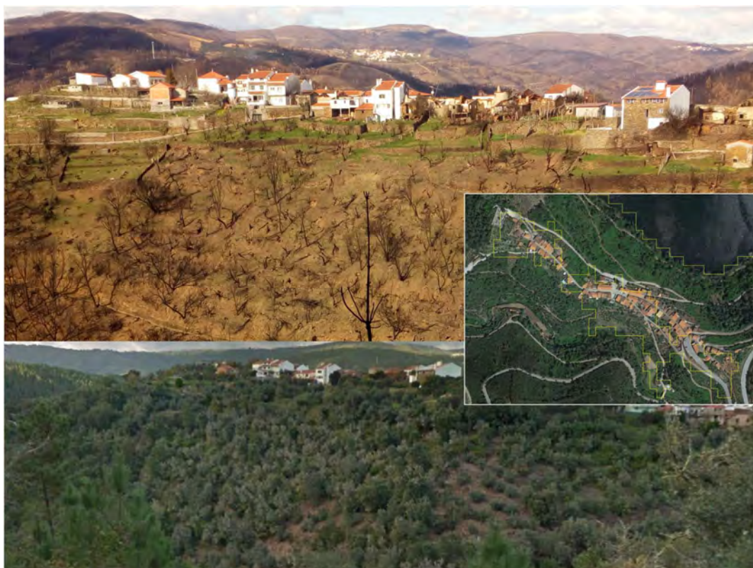
Figura 3.46. Em Álvaro, Oleiros, arderam cerca de 40 casas por ação do incêndio de Figueiredo-Sertã. A aldeia encima uma encosta ocupada por oliveiras e sobreiros. As fotos pré-fogo datam de 2013 e provêm do Google Earth .
